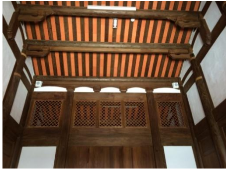
圖 9 第二進棟架現況
