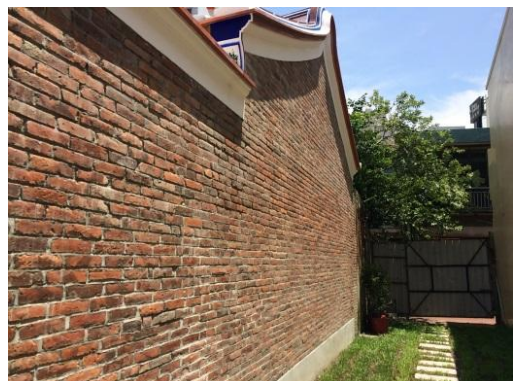
圖 16 左側立面照片
