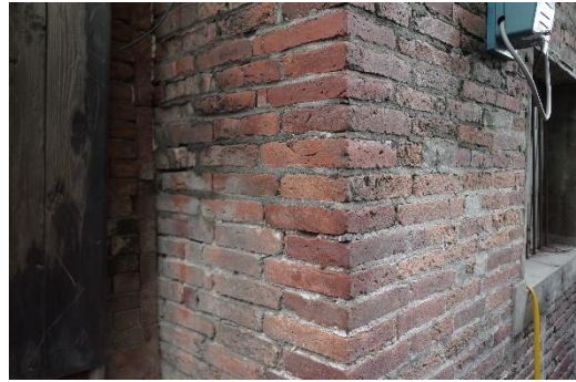
圖 2-2-29 順砌牆體 拍攝日期:2022.01.21
