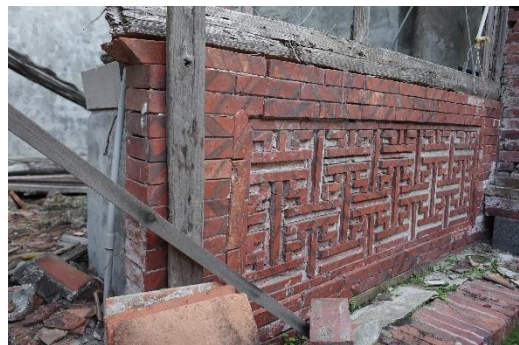
圖 2-2-31 面向中庭之左右兩側廂房寬約 12 公分紅磚(燕仔磚)牆(臺度)
