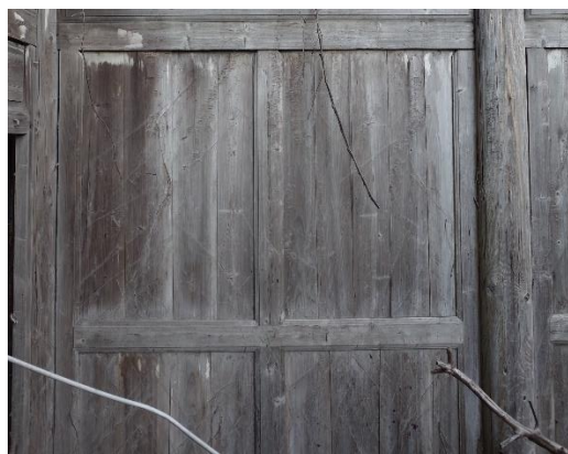
圖 2-2-48 具有線腳之第二進大廳木堵板牆 拍攝日期:2022. 01. 21
