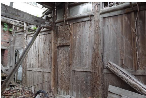
圖 2-2-36 穿鬪式木棟架「落地柱」 拍攝日期:2022.01.21
