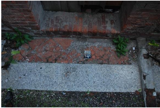
圖 2-2-9 入口處內縮簷下步口廊鋪面 拍攝日期:2022.02.06
