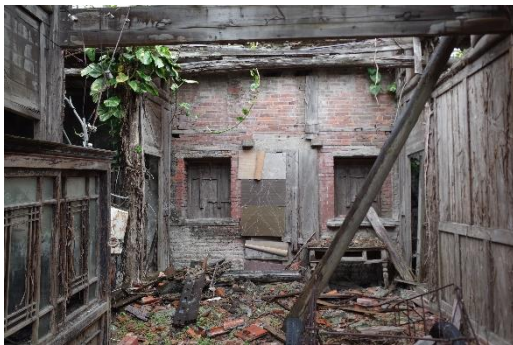
圖 2-2-4 第一進門廳現況 拍攝日期:2022.01.21
