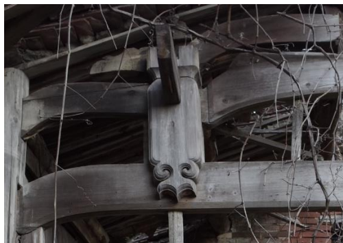
圖 2-2- 39 第二進大廳穿鬥式木棟架上短柱 拍攝日期:2022.01.21
