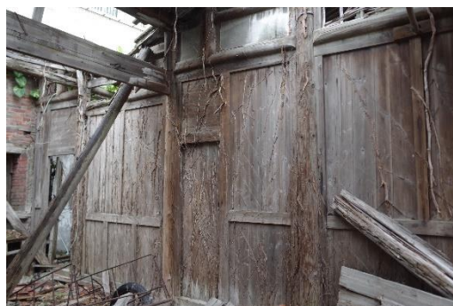
圖 2-2-47 第一進門廳木堵板牆 拍攝日期:2022. 01. 21
