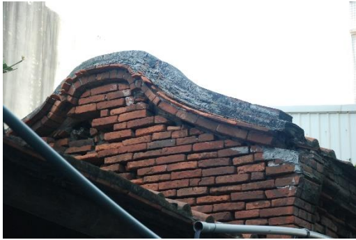
圖 2-2- 52 第一進第一部分卷棚式厝頂水形馬背收頭
