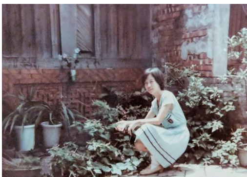
圖 2-2-32 面向中庭之兩側廂房燕仔磚牆上轉換木堵板牆 資料來源:許有正，拍攝日期不詳
