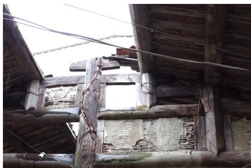
圖 2-2-46 第一進木棟架編泥牆 拍攝日期:2022. 01. 21
