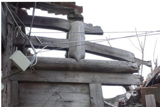
圖 2-2- 38 第一進門廳穿鬥式木棟架上短柱 拍攝日期:2022.01.21
