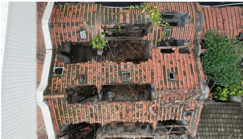
圖 2-2- 51 第一進厝頂現況空拍 拍攝日期:2022.01.21
