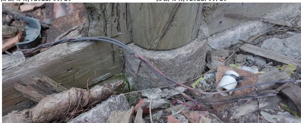
圖 2-2-50 柱珠與木柱尺度工藝差異 拍攝日期:2022. 02. 06
