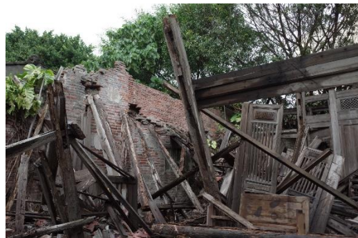
圖 2-2-5 第二進正廳現況 拍攝日期:2022.01.21
