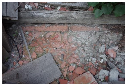
圖 2-2- 25 大廳簷廊使用 33 公分*33 公分面磚人字砌與室內鋪面丁字砌 拍攝日期:2022.02.06
