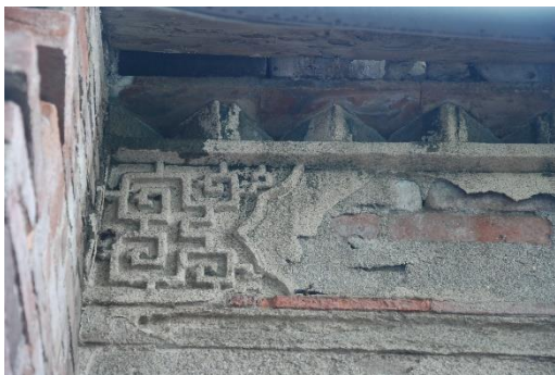
圖 2-2- 74 第一進入口上方的水車堵左右兩側堵頭現況 拍攝日期:2022. 02. 06
