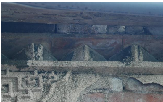
圖 2-2-30 第一進入口兩側簷下馬齒砌法(灰磚-明間)水平線條 拍攝日期:2022.01.21
