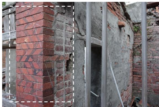
圖 2-2-35 中庭左廂房牆體新舊牆色澤差異 與交丁補強 拍攝日期:2022.02.06
