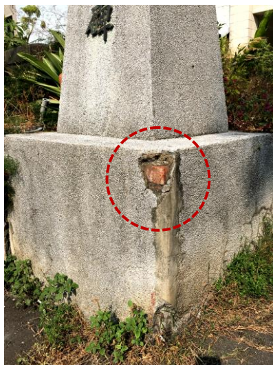
圖表 55：基座磚砌材料外露
