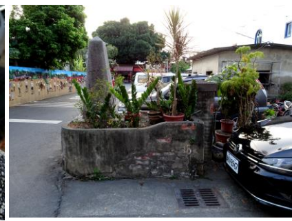
圖表 51：獸魂碑旁之花臺及門柱亦為磚砌，表面覆以水泥砂漿面層，作法不同。
