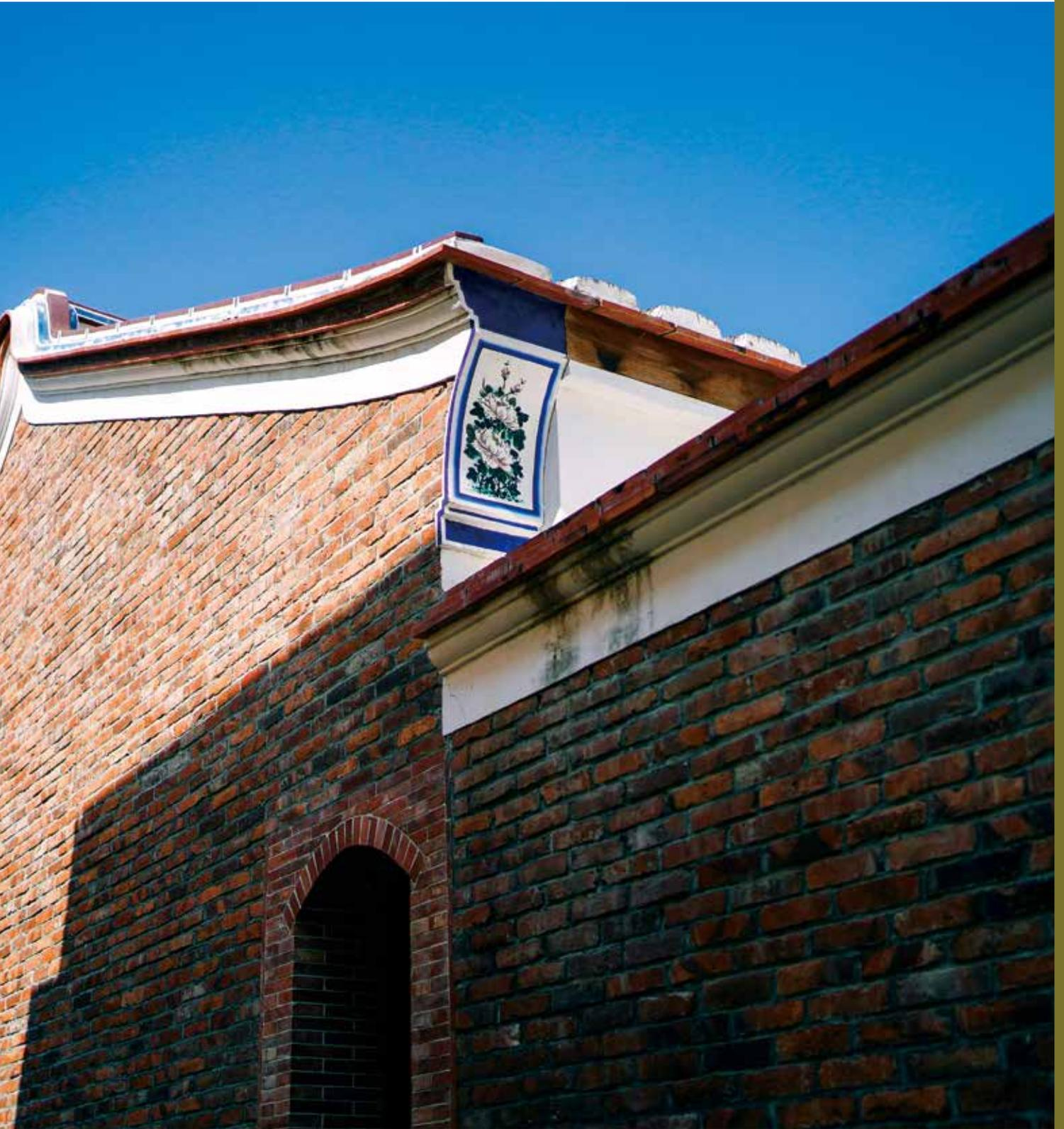
第一、二進左右的山牆，加入冂字型鋼骨補強，再利用紅磚包覆其中，盡可能以傳統工法及材料修復，但在構造中加入現代材料補強結構，加強建築安全及使用年限。
