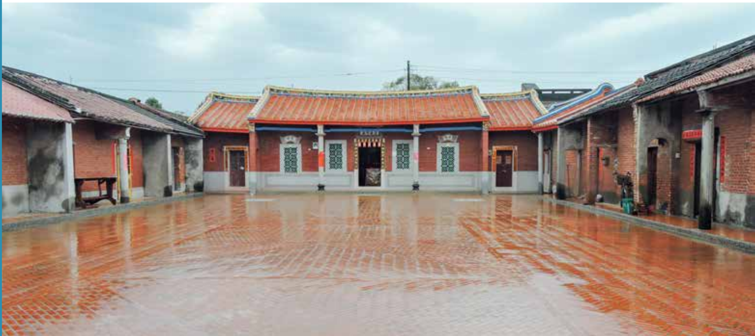
施家古厝修繕後的現貌。
